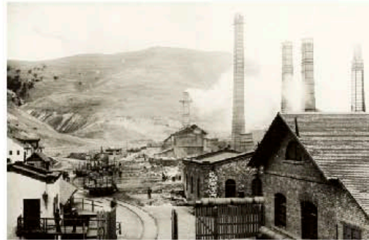
Gədəbəy misəritmə zavodu
