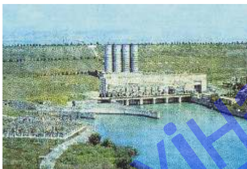
Kür çayı üzərində Mingəçevir su-elektrik stansiyası
