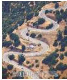
Dolama (serpantin) yol (Ağsu aşırımı)
