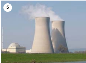
Elektrik stansiyalarının inşası
