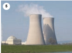
Elektrik stansiyalarının inşası
