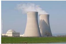
Elektrik stansiyalarının inşası
