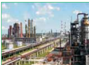
Бакинский нефтеперерабатывающий завод
