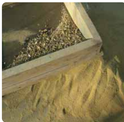
Песок, прежде чем использовать в строительстве, просеивают через специальные сита, имеющие мелкие отверстия.
