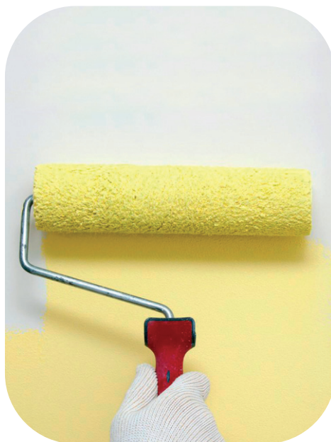
Рис. 2. Окрашивание поверхности изделий губчатым валиком
