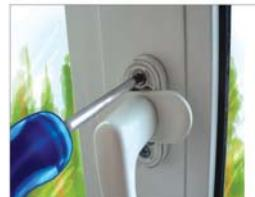
Рис. 5. Снятие ручки окна
