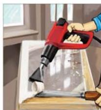
Рис. 2. Снятие старой краски строительным феном
