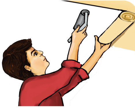
Şəkil 2. Tavana divar kağızının çəkilməsi
