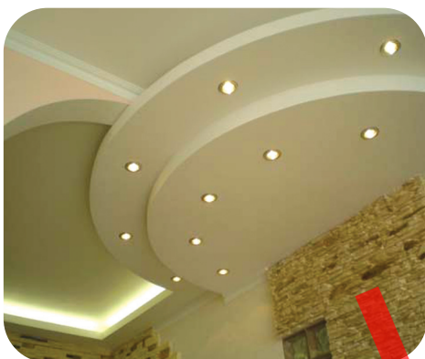
Şəkil 6. İşıqlandırması olan gipskarton lövhələrdən yığılmış asma tavan
