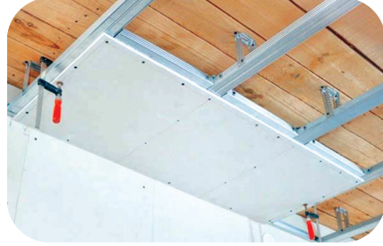
Şəkil 8. Gipskarton lövhələrin bərkidilməsi
