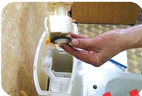
Şəkil 4. Pərdənin yenisi ilə əvəzlənməsi
